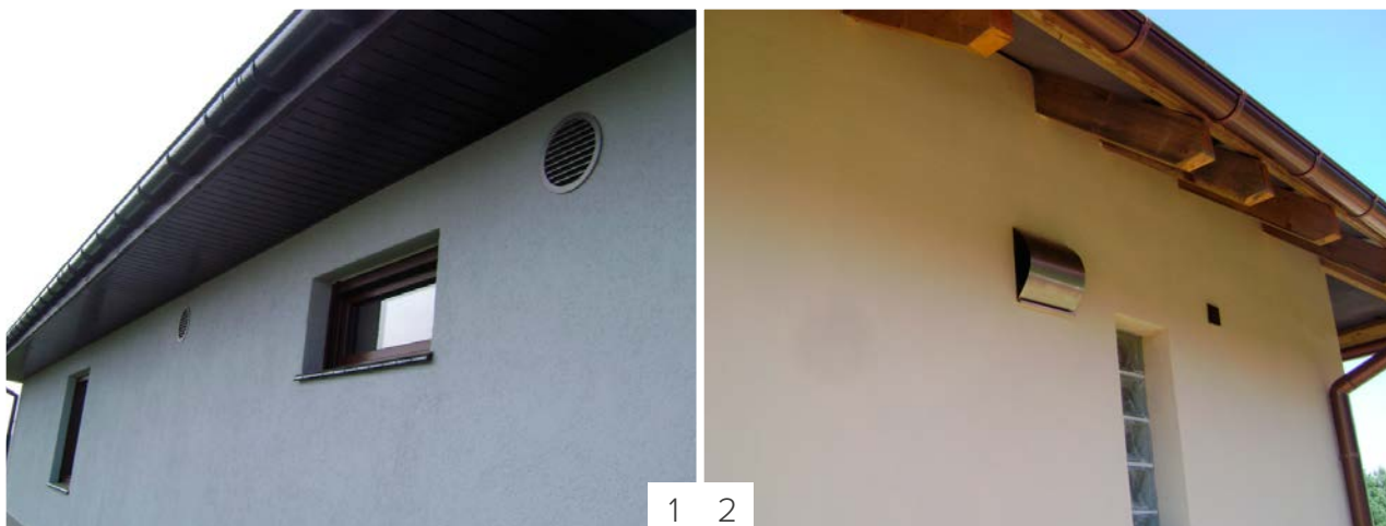
1. Standardowa czerpnia i wyrzutnia systemu rekuperacji. 2. Czerpnia/wyrzutnia LUNA: ciekawy kształt z dodatkowym okapnikiem chroniącym elewację przed powstawaniem zacieków od deszczu.
