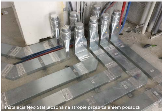
Instalacja Neo Stal ułożona na stropie przed zalaniem posadzki
