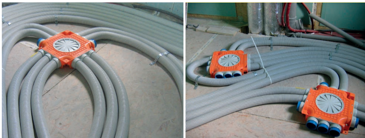
Instalacja wykonana w systemie NeoFlex GOLD z wysokiej jakości przetworzonego polietylenu o średnicy 63 mm pozwala na zalenie instalacji rekuperacji w posadzce.
