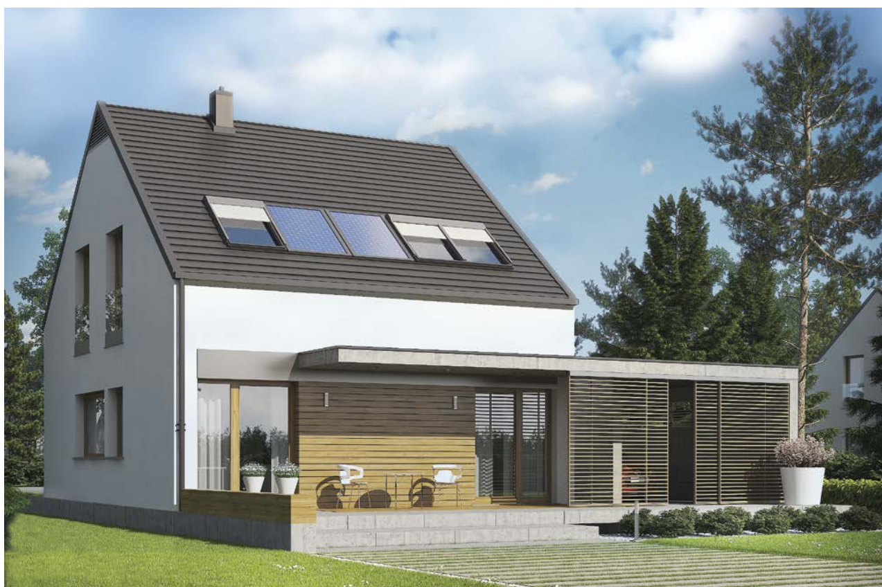
W domu z piecem gazowym, kominkiem i rekuperacją komin jest jeden lub najwyżej dwa - ostatecznie wynika to z układu pomieszczeń.
