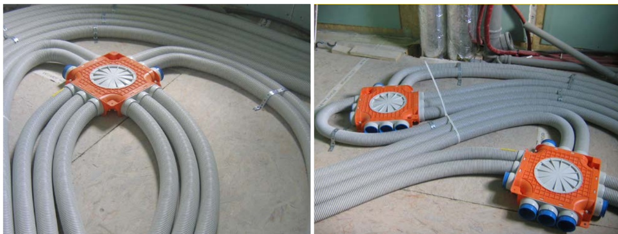
Instalacja wykonana w systemie R-VENT Flex z wysokiej jakości przetworzonego polietylenu o średnicy 63 mm pozwala na zalenie instalacji rekuperacji w posadzce.
